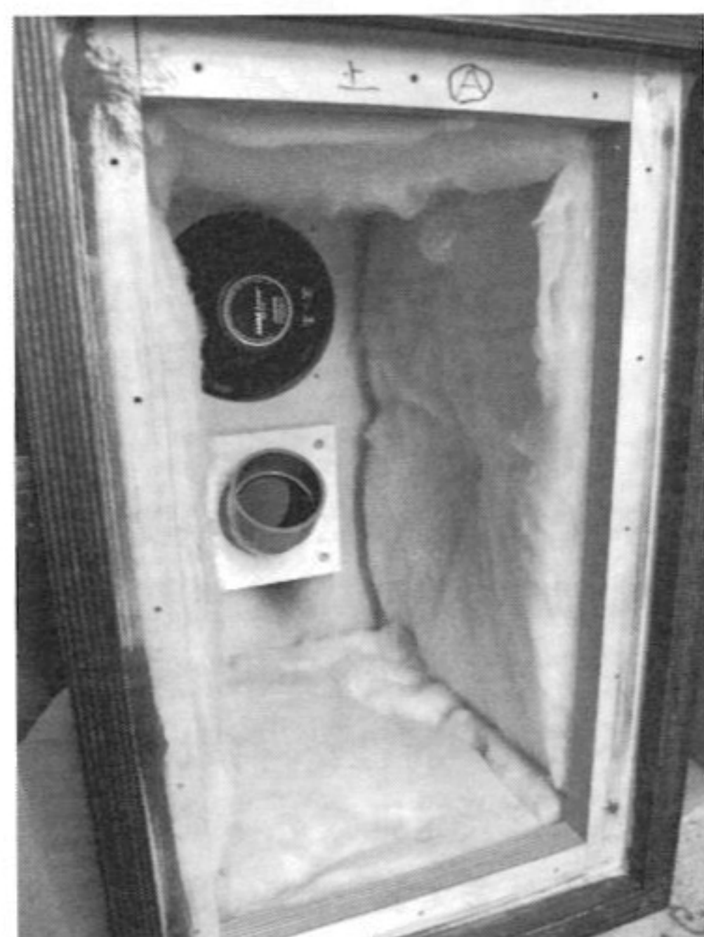
【写真17】 ユニット、ベントの取り付けとグラスウールの貼り付け
